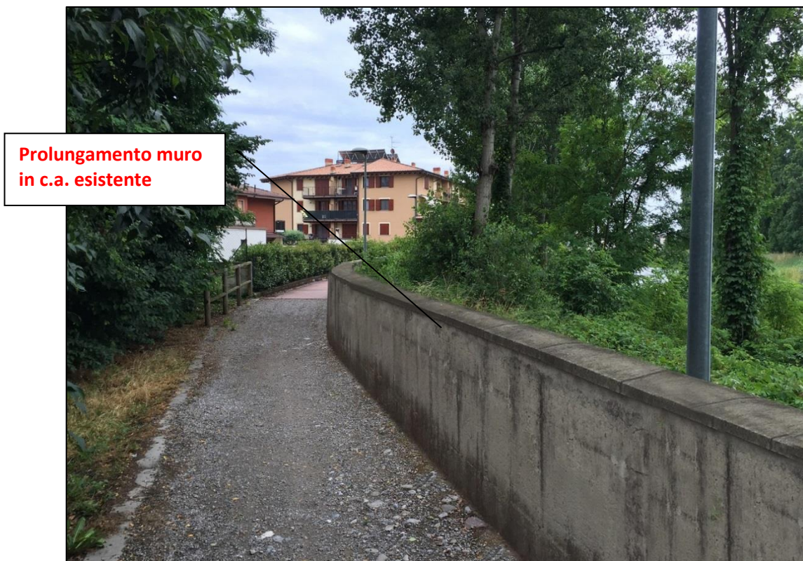
Figura 9. Area d'intervento (post operam) – Dettaglio prolungamento muro in c.a.
